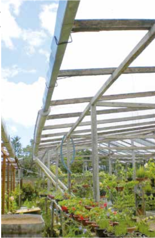
Figura 36. Empreendimentos com sistemas de captação de água da chuva, armazenamento e reaproveitamento desta em sistemas de irrigação, em Mosqueiro, PA.
